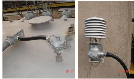
Fig. 6. Sensores de temperatura do topo do óleo (esquerda) e ambiente.
