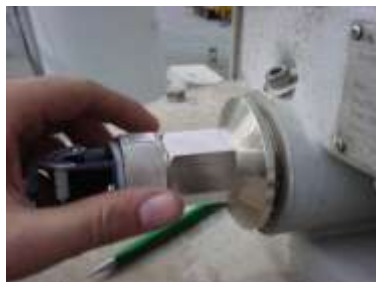
Figura 7: Instalação do adaptador de tap
