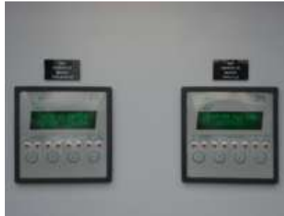
Figura 9: Instalação dos módulo de interface
