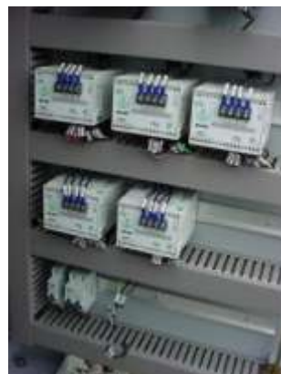
Figura 8: Instalação dos módulos de medição
