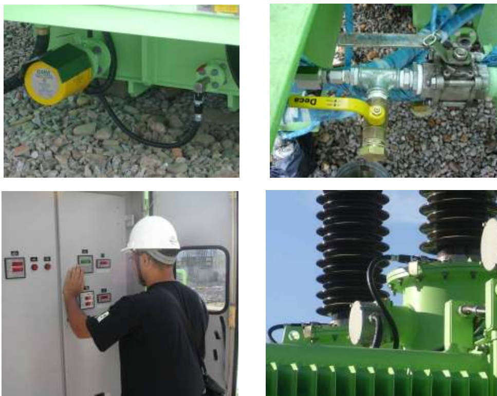
Figura 05 - Instalação dos sensores no transformador
