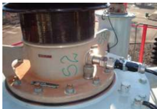
Fig. 3 – Conexão direta do sistema de monitoração ao tap de bucha do lado Fonte
