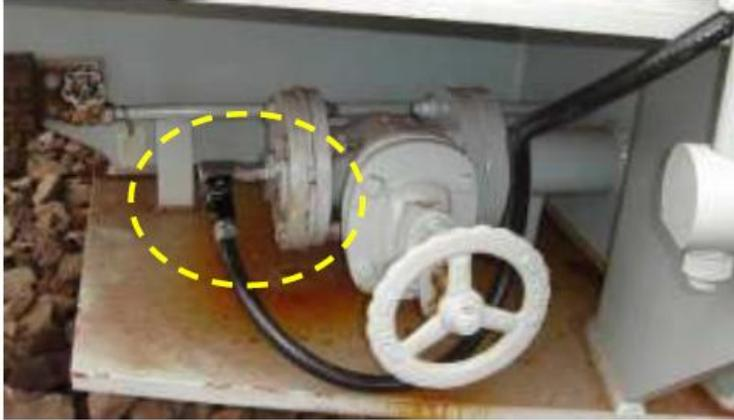
**Fig. 7 – Sensor de humedad en la válvula de drenaje del Regulador R1.**
