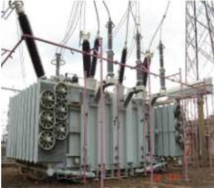
**Fig. 1 – Transformador Regulador R1.**
