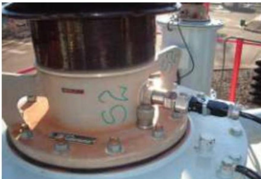
**Fig. 3 – Conexión derecha del sistema de monitoreo al tap de bushing del lado Fuente.**
