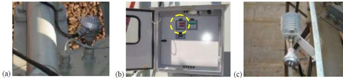
**Fig. 6 – Medición de temperaturas. (a) Sensor de temperatura del tope del aceite; (b) Monitor de temperatura del aceite y del punto más caliente del devanado; (c) Sensor de temperatura ambiente.**
