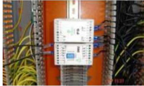
**Fig. 4 – Integración del monitor de gas existente en el Regulador R4 al sistema de monitoreo. (a) Sensor de hidrógeno; (b) Módulo de adquisición de datos para integración.**
