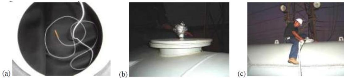
**Fig. 8 – Instalación del sensor de ruptura de membrana del tanque de expansión. (a) Sensor sobre la membrana, en el interior del tanque; (b) Caja de conexión en el tope del tanque; (c) Conexión del cable del sensor.**
