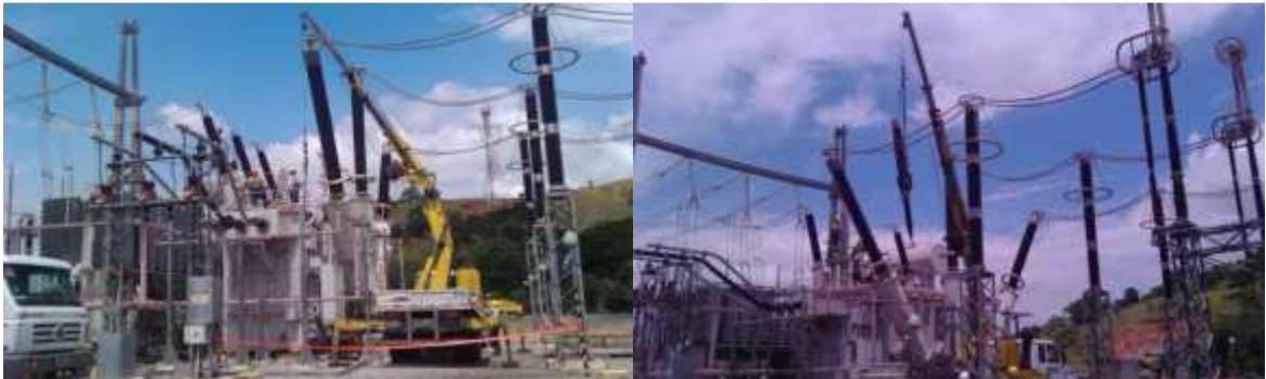
Figura 07: Equipe Cemig realizando a troca da bucha defeituosa.
