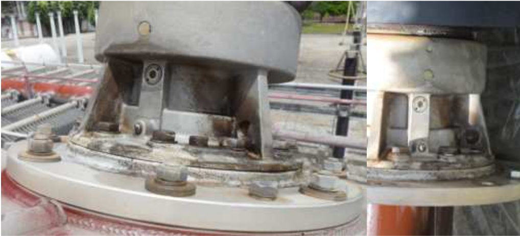
Figura 06: Equipe Cemig realizando a troca da bucha defeituosa.
