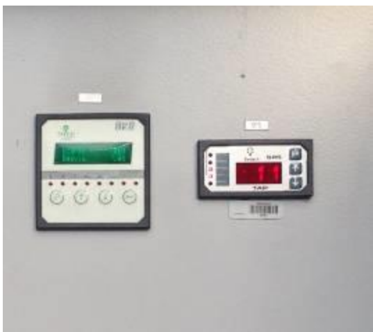
Fig. 06 - Regulador de Tensão e Supervisor de Paralelismo
